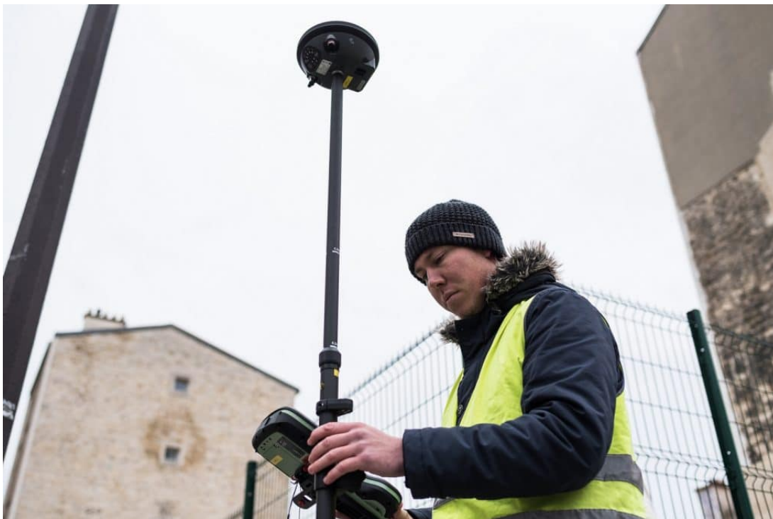
Alternant en BTS géomètre-topographe au GPI2D utilisant un GNSS sur un chantier.
